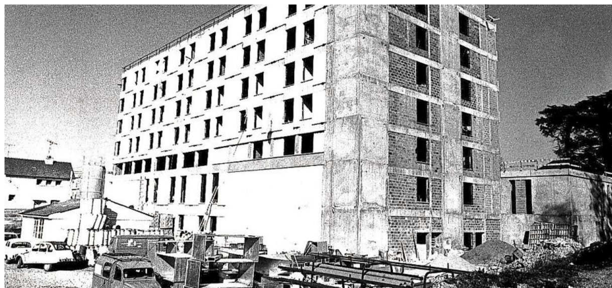
L'hôpital, vu de l'opposé du grand escalier, est en construction en 1972. La taille des ouvertures du pignon, qui deviendront entrées des futurs couloirs dans l'extension de la seconde tranche (1982) montre que la construction majeure était financée en deux temps.
